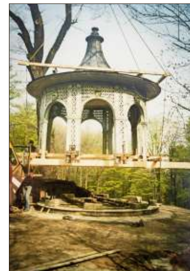
Da hängt das Salett'l am Kran-Haken zum Versetzen.
